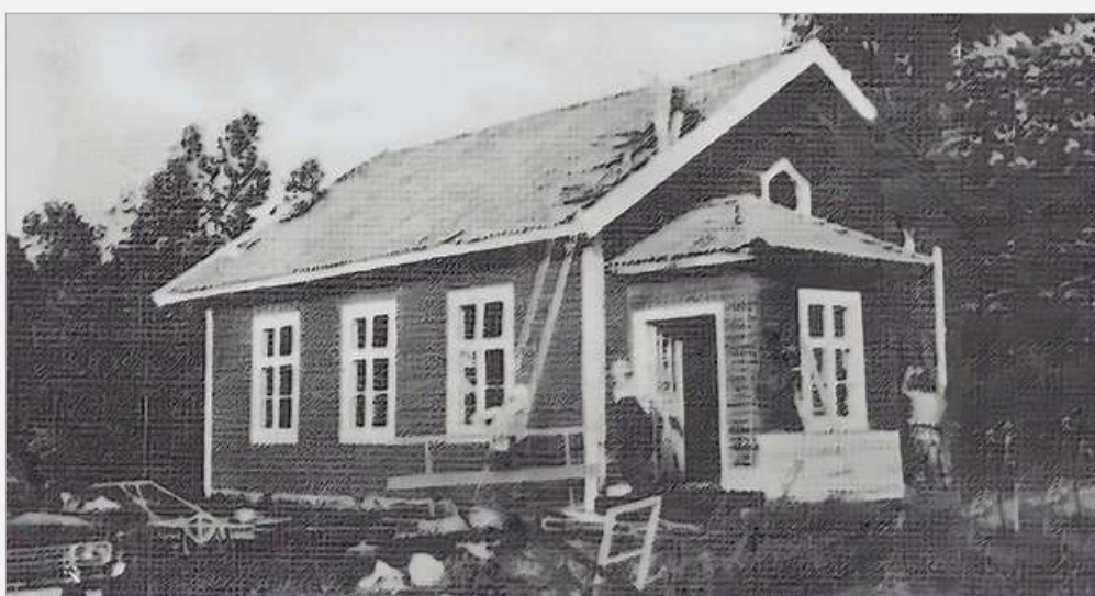
Utvändig reparation år 1979.
