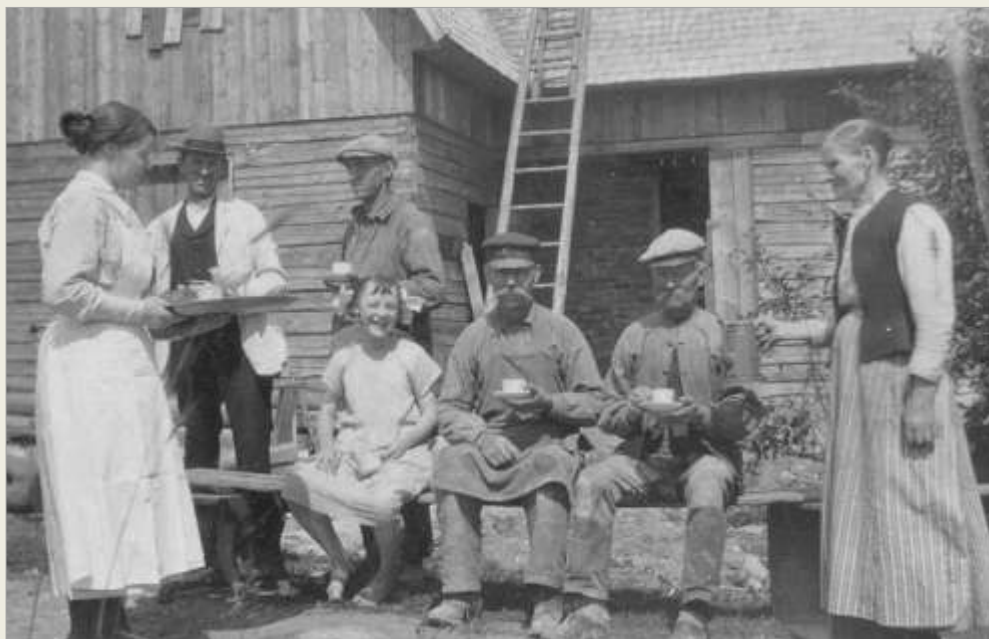
Den så kallade Villan, på gränsen mellan Stora och Lilla Smedsbol, är under uppförande.
