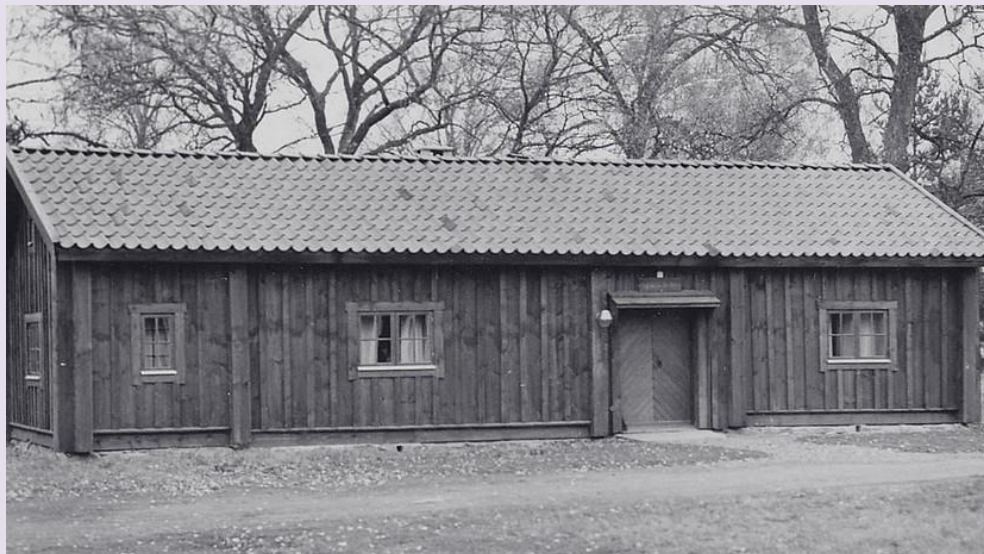
Den äldsta skolan, i renoverat skick.
