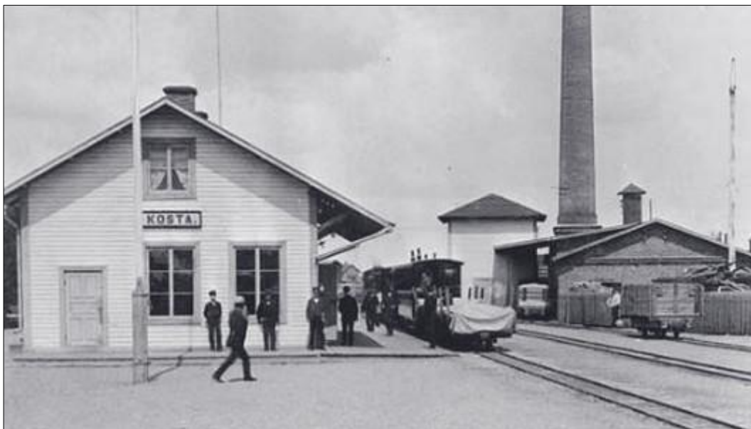
Kosta järnvägsstation (vykort). Man anar att fabriksskorstenen fortsätter en bit till.
