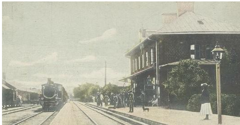
Tranås järnvägsstation, tidigt 1900- tal (vykort).
