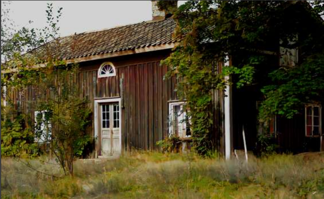
Familjen Mobergs äldsta bostadshus i Barrud
