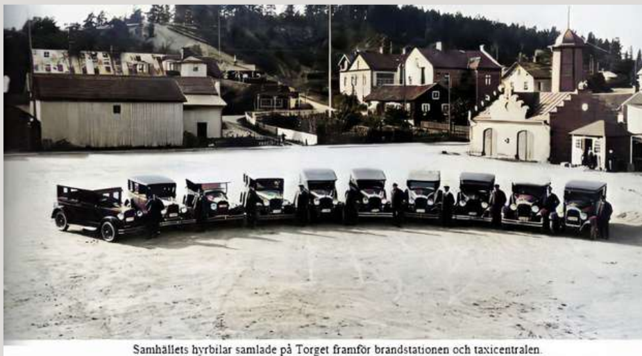
Samhällets hyrbilar samlade på Torget framför brandstationen och taxicentralen.
